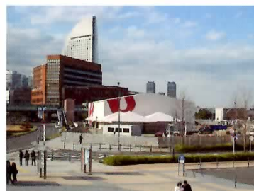
JICA横浜の前で建設が進むベイサイド会場
