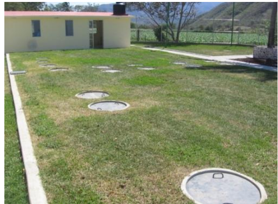
テペチコトランの PTAR (3 月 11 日)
