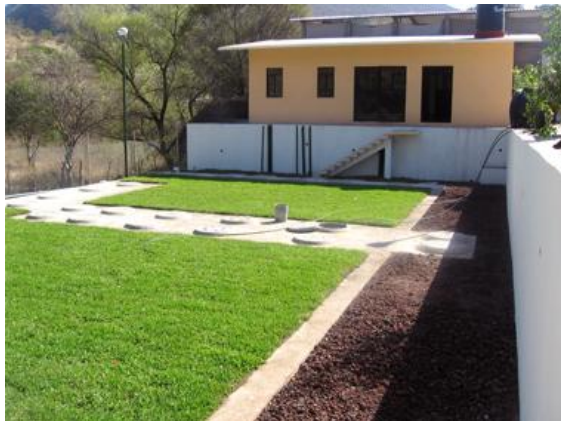
アモヒレカの PTAR (3 月 6 日)
